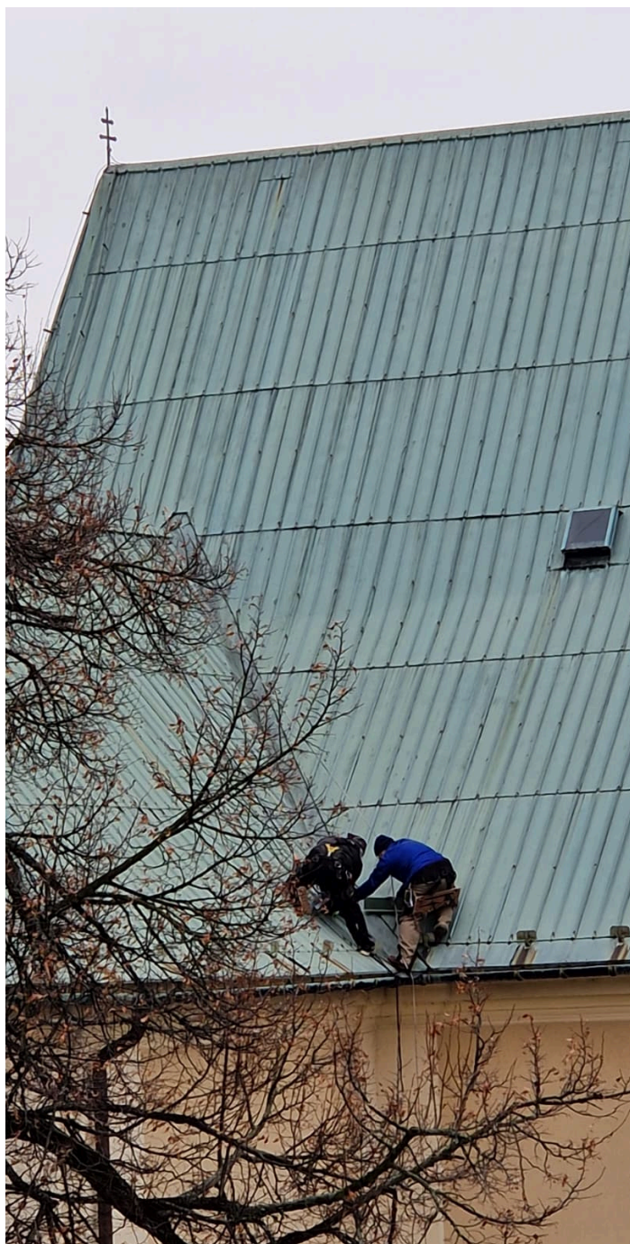
Montáž protilavinových zábran, listopad 2025
